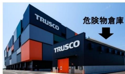
HC東日本物流センターの危険物倉庫
